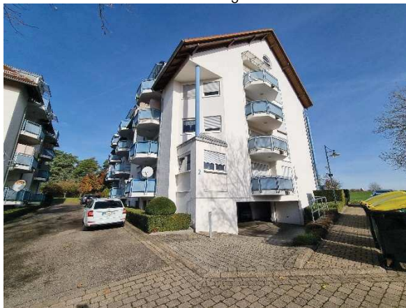
Zugang TG Fichtenweg 2
