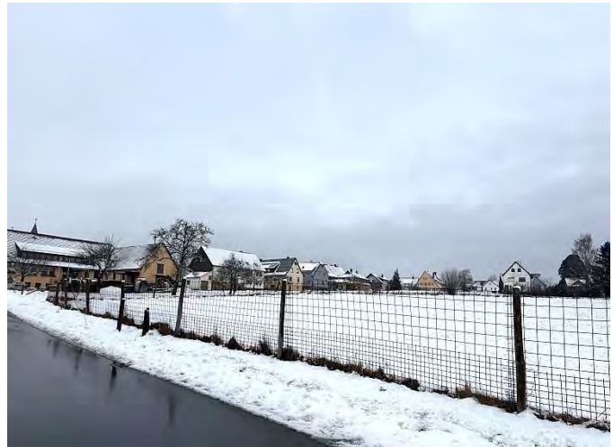
(10) Bewertungsobjekt = eingezäuntes Grundstück
