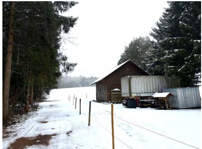
(1)Zuwegung Forstweg bis zu diesem Gebäude das im Liegenschaftsplan blau markiert ist
