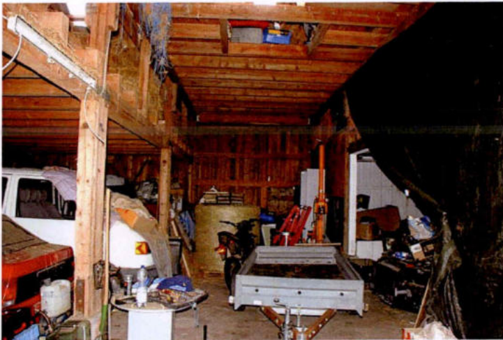
(13) Scheune EG mit Lagergut
