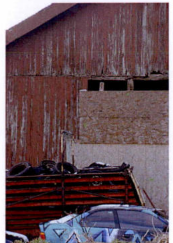
(5) Detail Bauzustand Holzfassade
