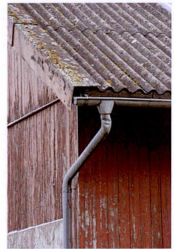
(3) Detail asbesthaltige Dachwelle
