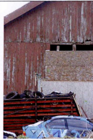
Baumängel, Bauschäden und instandhaltungsrückstau Holzfassade
