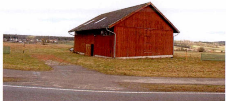
(1) Ansicht Südwest von der Badstraße
