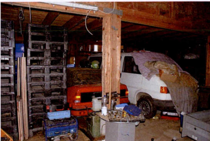
(17) Scheune EG mit Lagergut
