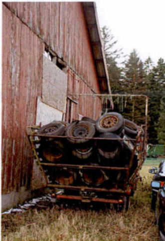
(6) Dito Lagergut auf dem Grundstück
