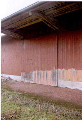
(8) Detail Bauzustand Fassade
