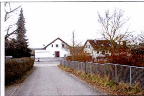
Zaunanlage am Scheuffelteilweg
