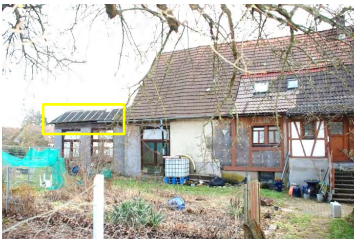
(71) Dito Detail Nordfassade Schuppenanbauten, Scheuer und Wohnhaus
