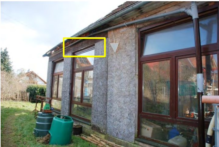
(73) Detail Außenfassade Schuppenanbau
