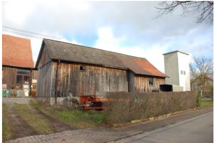
(87) Ansicht von der Raiffeisenstraße auf Nebengebäude / Schuppen und Garage
