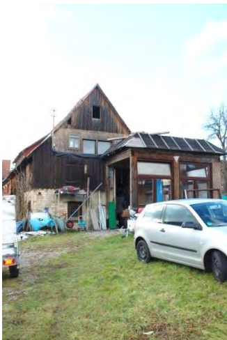
(68) Ansicht Ost Schuppenanbauten
