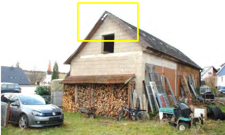
(88) Ansicht Ost / Nebengebäude
