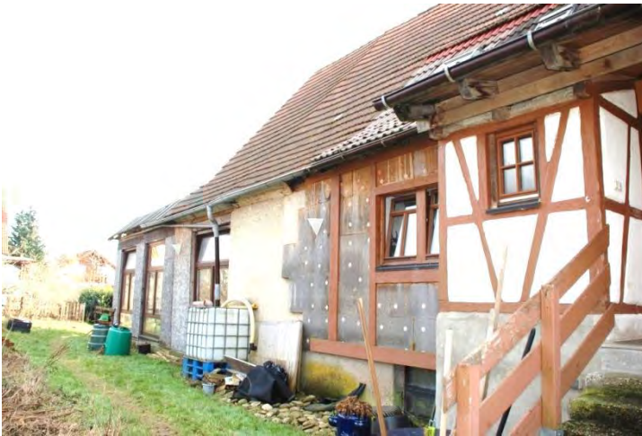
(10) Detail Fassade Wohnhaus Scheuer und Schuppenanbau
