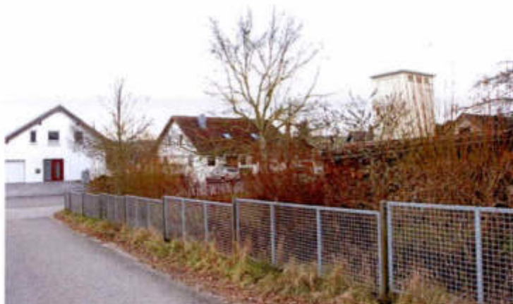
(4) Blick auf das Bewertungsobjekt vom Scheuffelteilweg und Umgebungsbebauung an der Raiffeisenstraße
