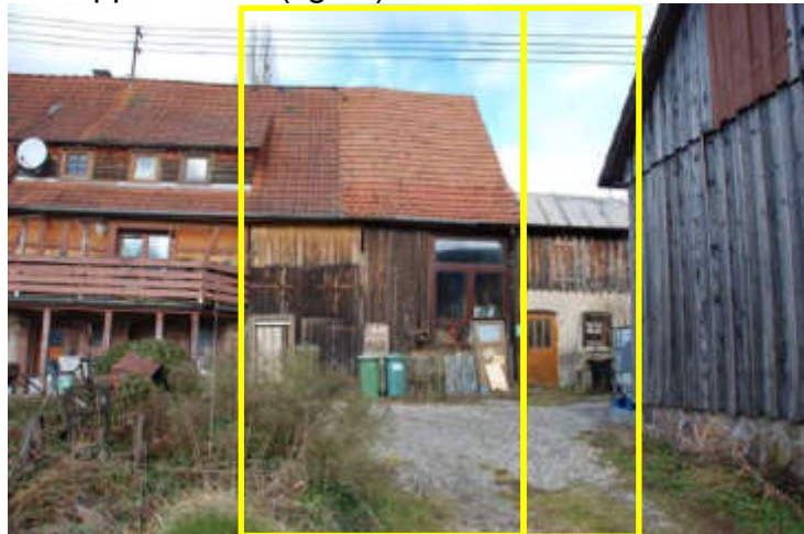
(2) Ansicht Süd von der Raiffeisenstraße Scheuer (vgl. 2), Schuppenanbau (vgl. 3)
