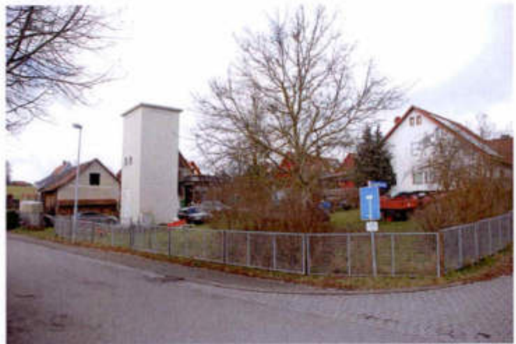
(2) Ansicht von der Ecke Raiffeisenstraße und Scheufelteichweg
