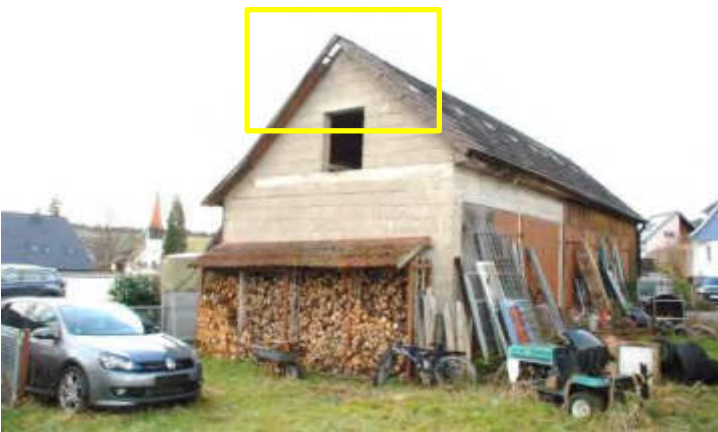
(88) Ansicht Ost / Nebengebäude
