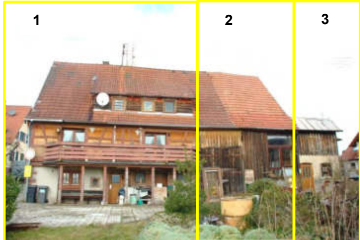
(1) Ansicht Süd von der Raiffeisenstraße Wohnhaus (vgl. 1) mit Scheuer (vgl. 2) und Schuppenanbau (vgl. 3)
