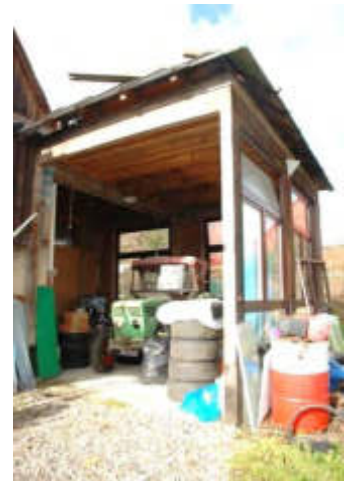
(70) Schuppenanbau als Unterstand für Traktor mit provisorischem Dach
