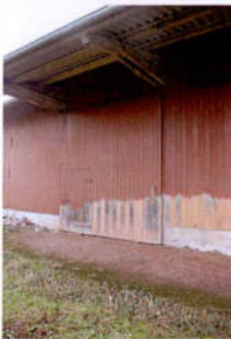
(8) Detail Bauzustand Fassade
