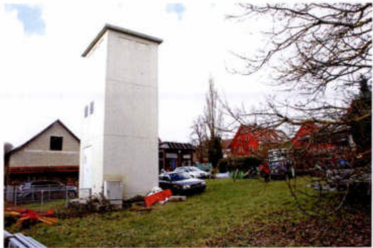
(7) Elektrostromstation auf Nachbargrundstück Flst. Nr. 367
