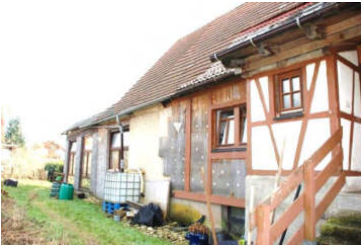
(10) Detail Fassade Wohnhaus Scheuer und Schuppenanbau
