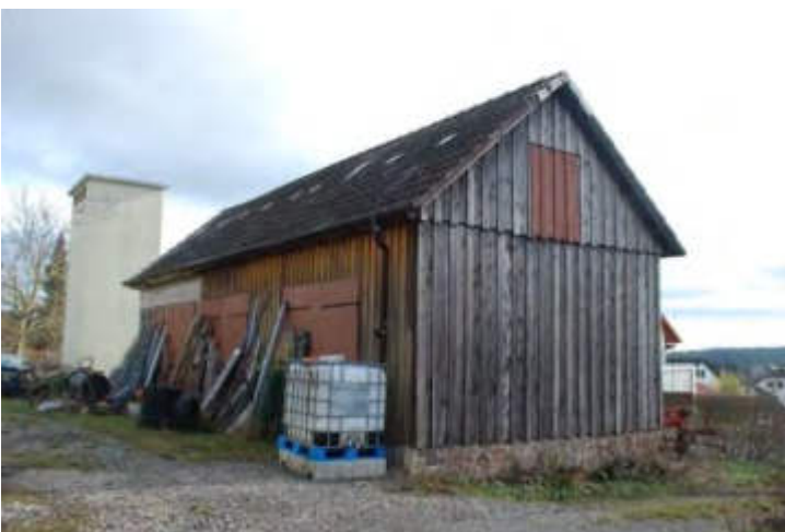
(90) Ansicht Nord – West / Nebengebäude
