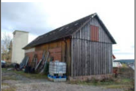
Nebengebäude Geräte + Garage
