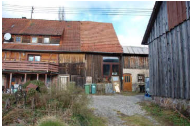
(101) Zufahrt (Kiesschotterfläche) zur Scheune, Schuppenanbau und Nebengebäude
