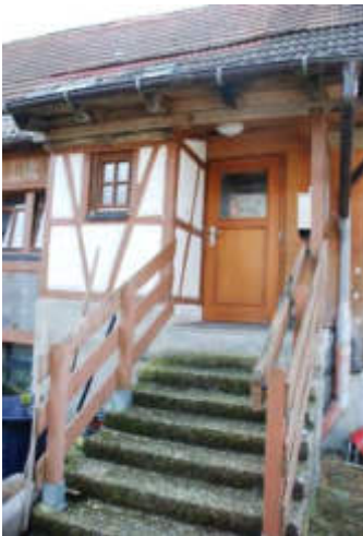
(12) Treppe zum Hau- seingang Wohnhaus
