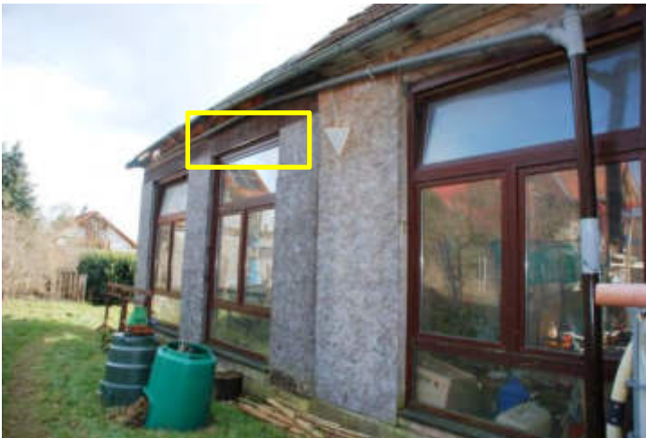
(73) Detail Außenfassade Schuppenanbau
