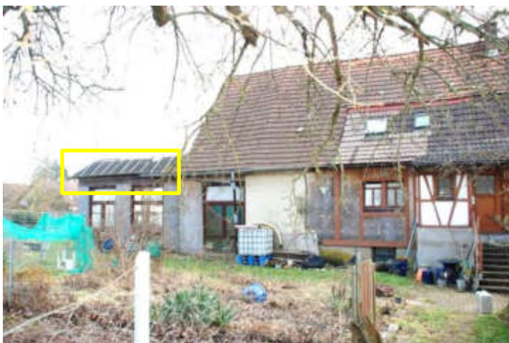
(71) Dito Detail Nordfassade Schuppenanbauten, Scheuer und Wohnhaus
