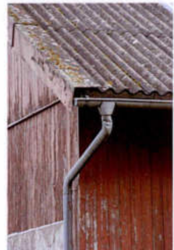
(3) Detail asbesthaltige Dachwelle
