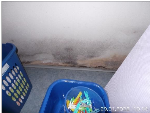
Fotos 20 - 23 Feuchteschäden im Keller; schadhafter Belag auf der Außentreppe
