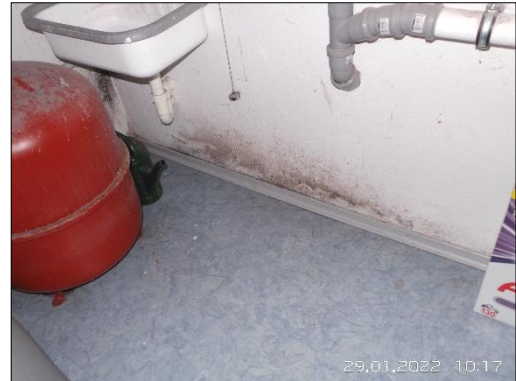
Fotos 20 - 23 Feuchteschäden im Keller; schadhafter Belag auf der Außentreppe
