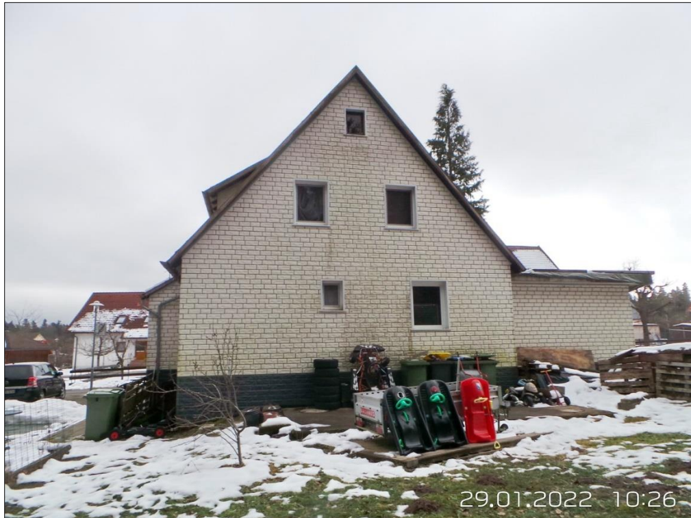
Anlage 5 Fotos 5 - 6 Ansichten von Nordwesten und Südosten (mit überdachter Loggia und ehem. Rollstuhlrampe)
