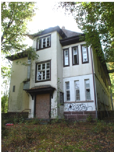
Foto Nr. 3: Ansicht Haus 1 von Osten
