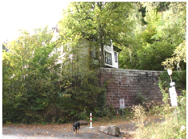
Foto Nr. 4: Ansicht Haus 1 von SO
