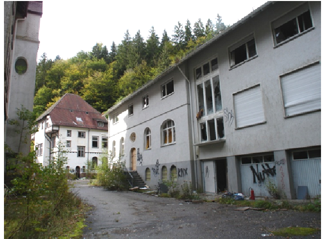
Foto Nr. 20: Ansicht Haus 9 von SO
