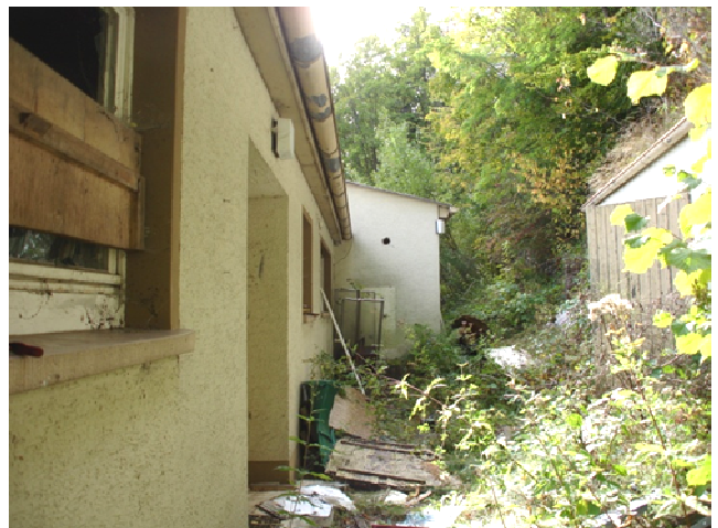
Foto Nr. 28: Ansicht Haus 3 entlang der NW-Fassade
