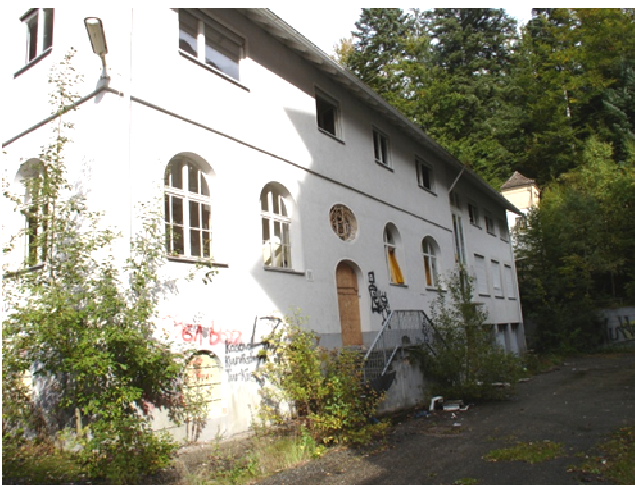
Foto Nr. 17: Ansicht Haus 9 von SW vom Hof
