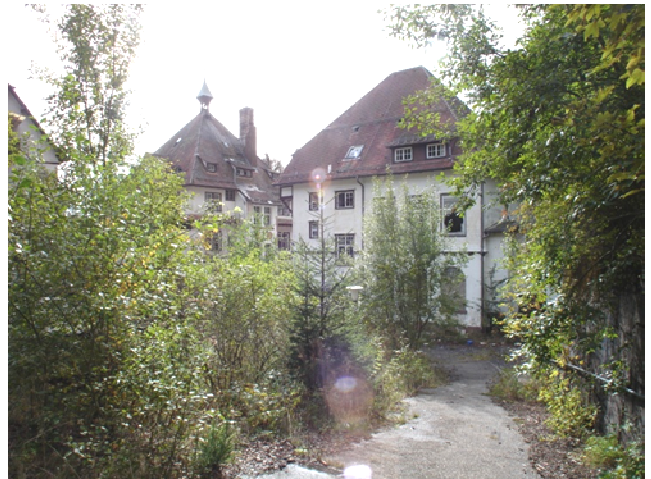
Foto Nr. 16: Ansicht Haus 4 u. 5 von NO
