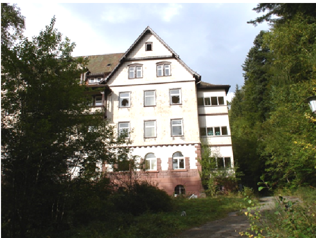
Foto Nr. 21: Ansicht Haus 6 von Süden
