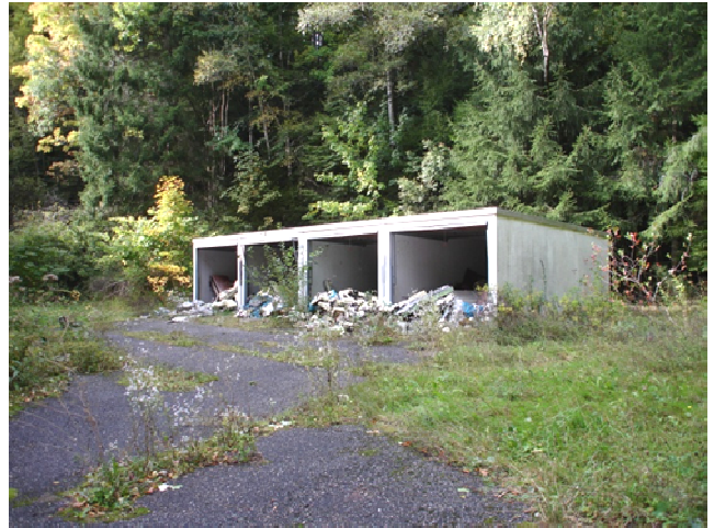
Foto Nr. 26: Ansicht Garagen an Haus 7 von SO
