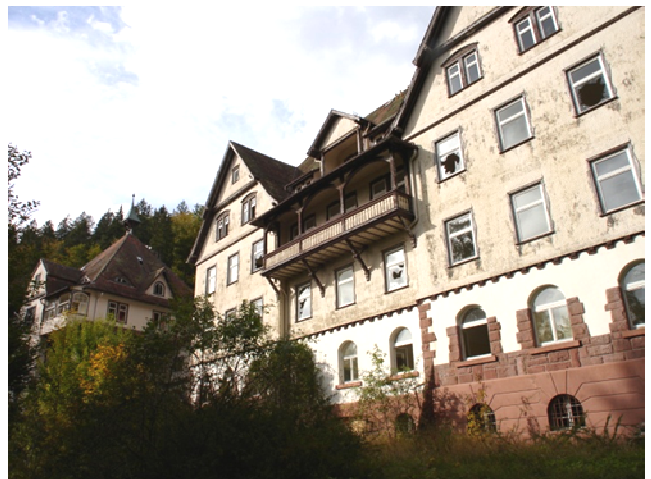
Foto Nr. 22: Ansicht Haus 4 u. 6 von SO
