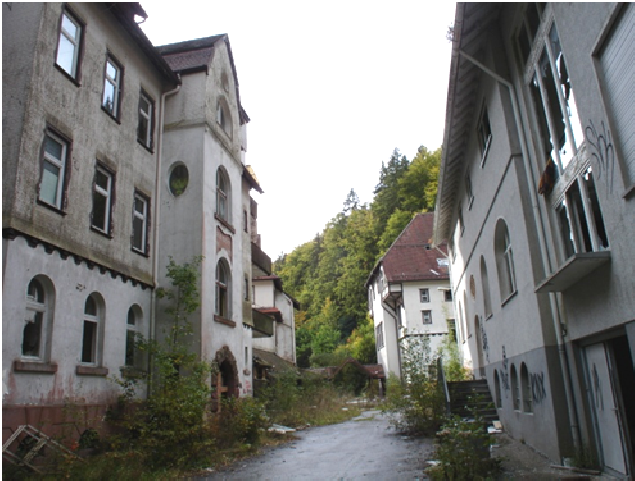
Foto Nr. 19: Blick von Osten in Richtung Hof mit Haus 5, 6 u. 9
