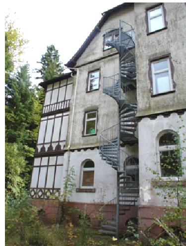
Foto Nr. 18: Ansicht Haus 6 von NW vom Hof
