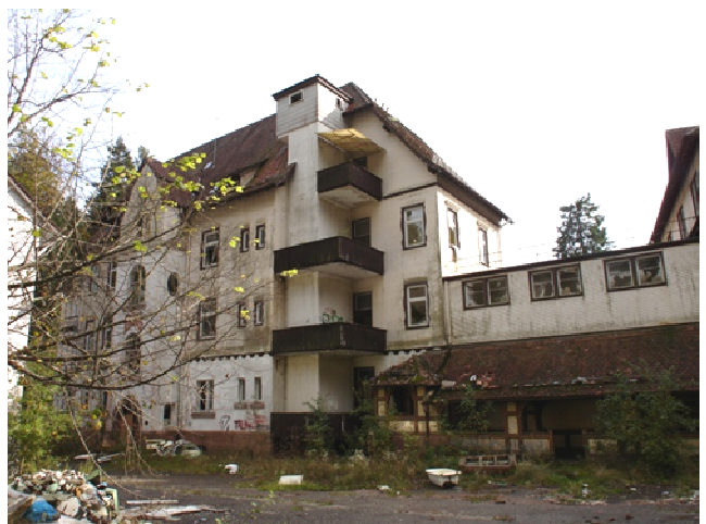
Foto Nr. 12: Ansicht Haus 6 von NW vom Hof
