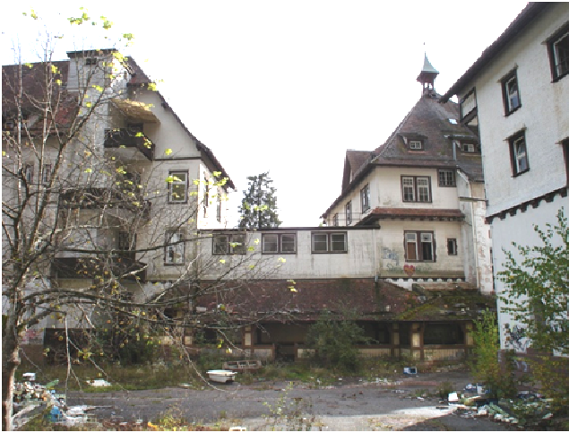
Foto Nr. 13: Ansicht Haus 4 u. 6 von Norden vom Hof
