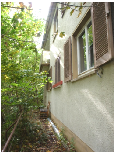
Foto Nr. 27: Ansicht Haus 3 entlang der SO-Fassade
