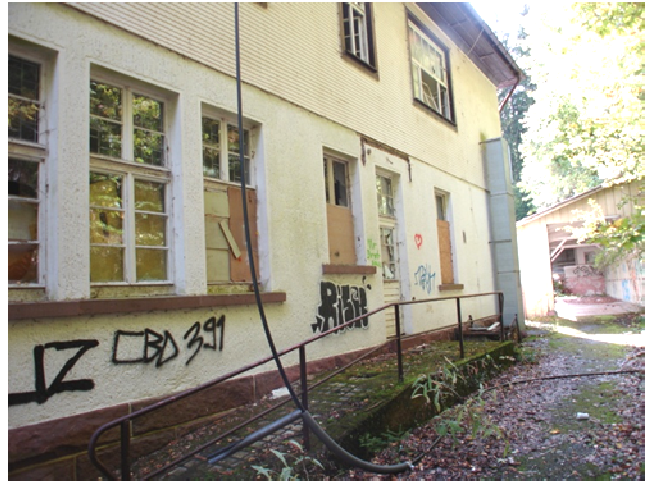
Foto Nr. 2: Ansicht Haus 1 entlang der Nordfassade
