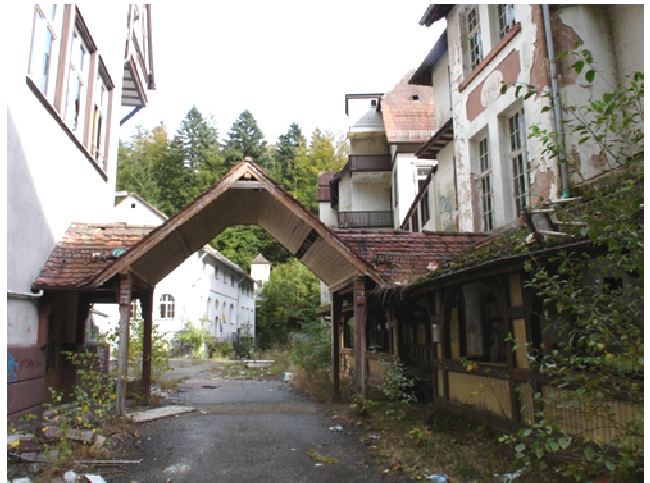
Foto Nr. 8: Ansicht überdachter Übergang zwischen Haus 4 u. 5 von Westen
