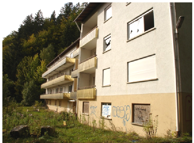
Foto Nr. 24: Ansicht Haus 7 von SO
