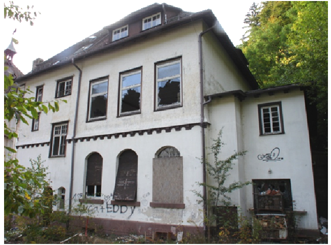
Foto Nr. 14: Ansicht Haus 5 von NO vom Hof
