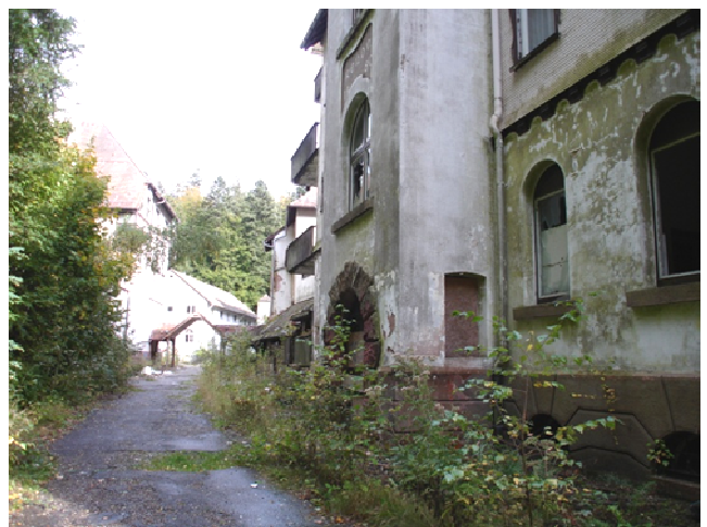
Foto Nr. 6: Ansicht Haus 2 entlang der Nordfassade
